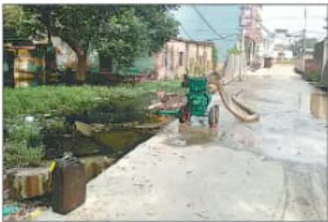
धामपुर में लोक निर्माण विभाग के प्रवासीय परिसर में भरे बाहिरा के पानी को पंप लगाकर निकाला जा रहा है। संवाद
